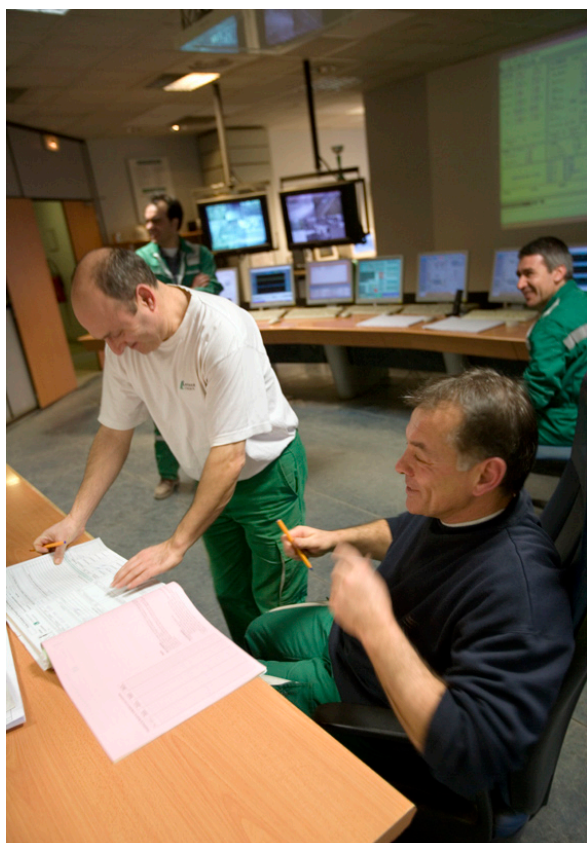
Salle centrale de l'usine de Bouc-Bel-Air (13)
