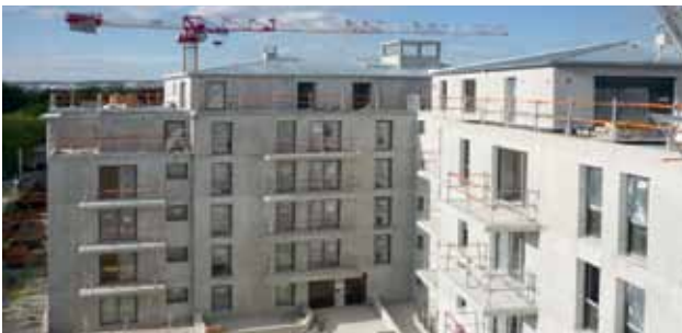
Logements collectifs Thermedia™ en Île-de-France
