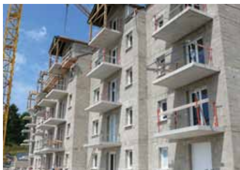
Résidence les Berges de la Loire à Gien [45]
