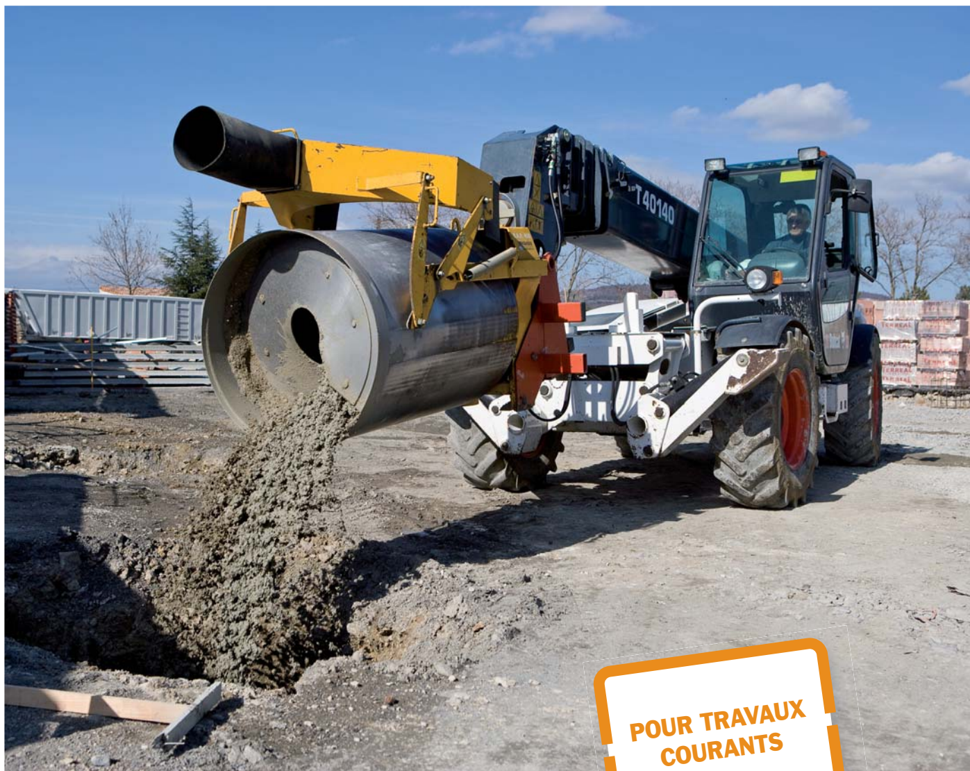
LE CLASSIC® Coulage de fondations, semelles isolées.
