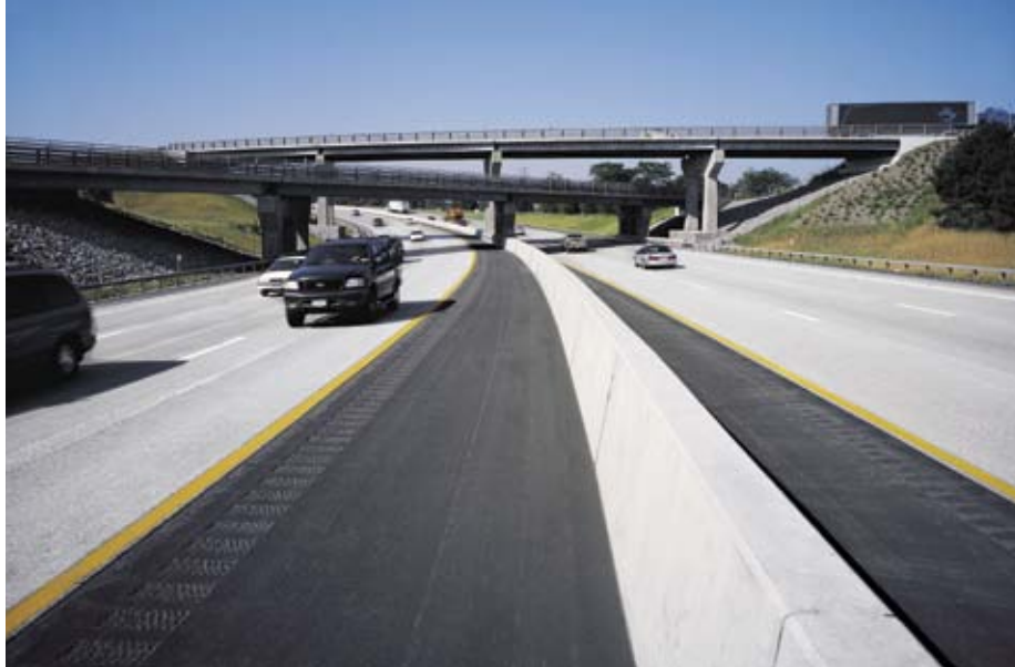
Les produits à base de bitume recyclé permettent d'économiser des granulats. Autoroute en béton entre Rochester et Buffalo, New York, Etats-Unis. © Médiathèque Lafarge - K.C. Kratt - GPA - New York State Department of Transportation Region 4 - Authority New York State Thruway - Transportation Parson - Ressel Howard (architecte)
